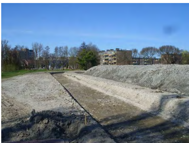
Figuur 3. In 2012 werden de dijkes opgetrokken uit klei afkomstig van de geulen ernaast. In dit jaar zijn de dijkes nog volledig kaal. Foto Hans Erren - CC BY-SA 3.0 (Wikipedia).
